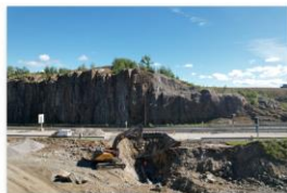
Bilde fra deler av anleggsområde ved E18. Foto: Eiffage Génie Civil
